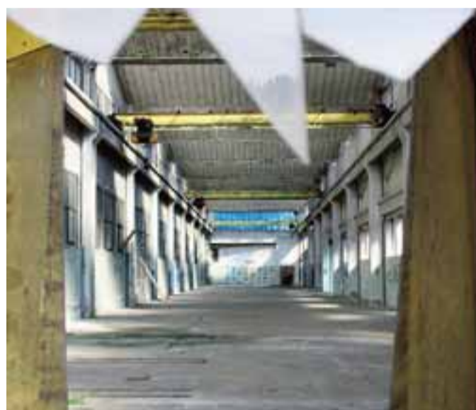
Una vista interna del capannone FOTO COLLEONI
